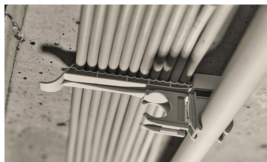
Mit Hilfe eines EC Euro-Clips lässt sich auch ein Rohr am KBS mittig befestigen.
