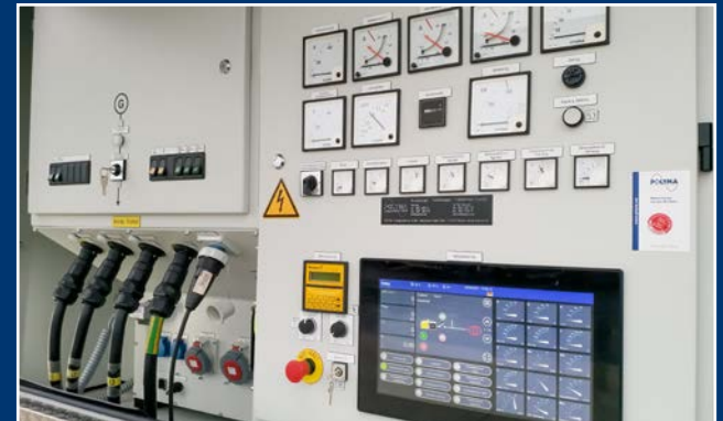
Der Leistungsteil ist serienmäßig mechanisch getrennt vom Steuerteil aufgebaut. Der 15" Touchdisplay beinhaltet alle Anzeigen, kann jedoch um analoge Instrumente ergänzt werden.
